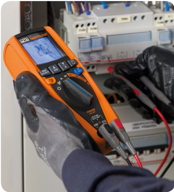
Mesure de tension avec des cordons de test.
