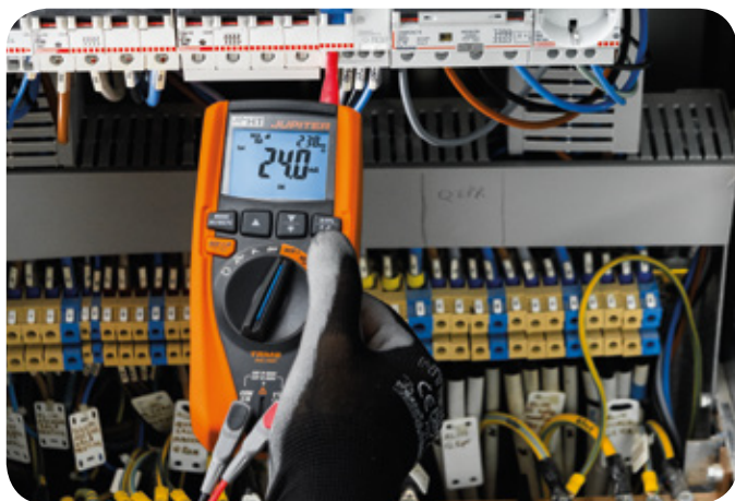
Temps de déclenchement du RCD et mesure du courant.
