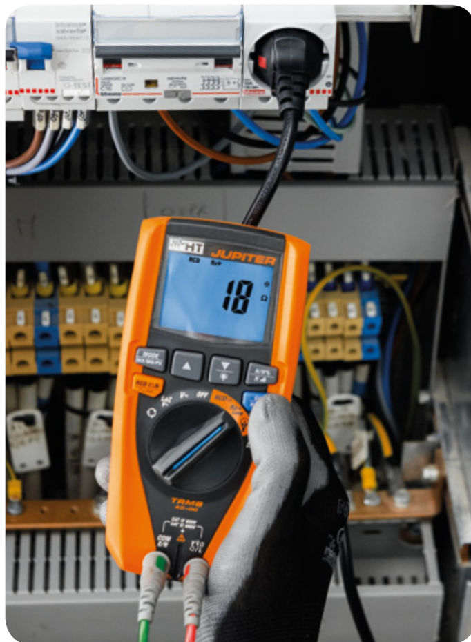
Mesure de résistance à la terre sans déclenchement.
