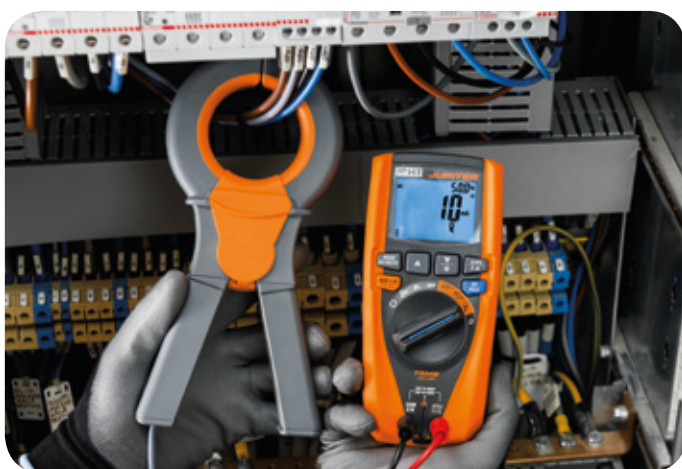
Mesure du courant de fuite.
