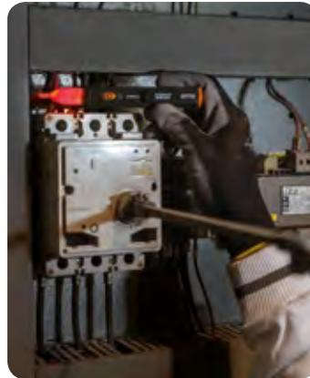
**Étape 1** - Prendre le HT70 et le laisser sur la phase L1 du système triphasé (sur le conducteur ou la gaine) pendant **au moins 5 s** et attendre que la **LED rouge** clignote en même temps que le buzzer se déclenche.
