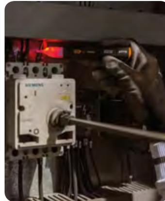
**Étape 2** - Puis, maintenir le HT70 sur la phase L2 (sur le conducteur ou la gaine) pendant **au moins 5 autres secondes** et attendre que la **LED** clignote en même temps que le buzzer se déclenche.
